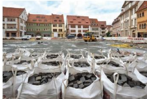
Erneuerung des Pflastermaterials auf dem unteren Hauptmarkt im Sommer 2020
